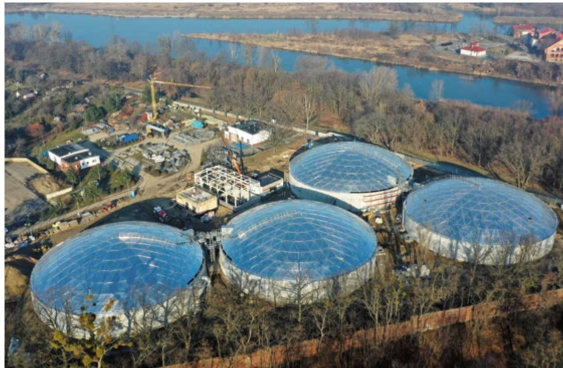
Oprócz zbiorników powstaje też przepompownia ścieków, sieć rurociągów i komór technicznych
